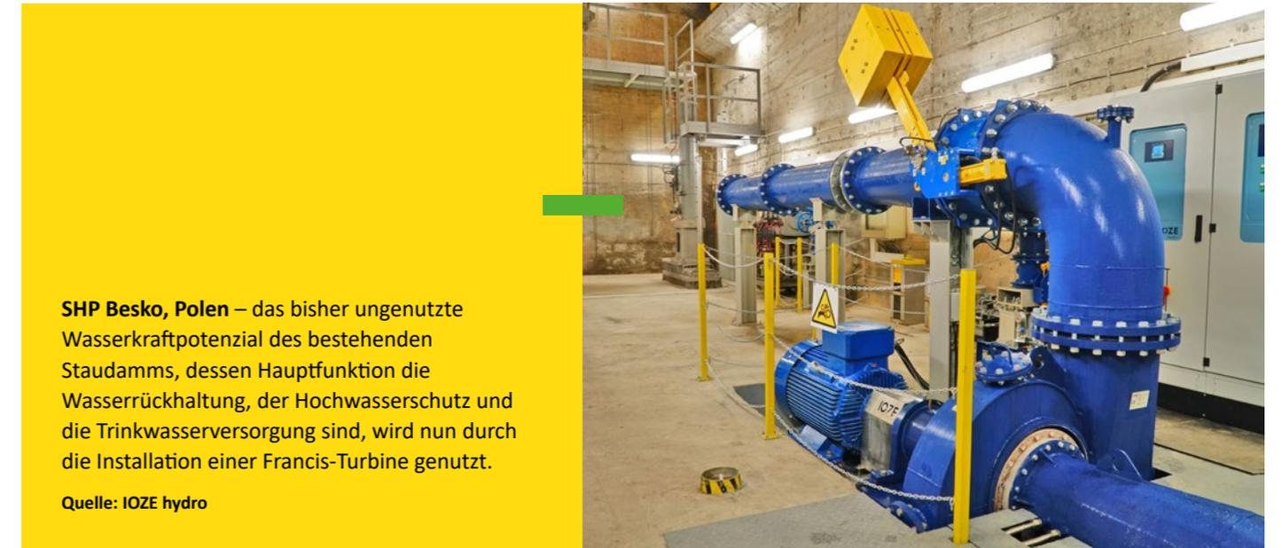
**SHP Besko, Polen** – das bisher ungenutzte Wasserkraftpotenzial des bestehenden Staudamms, dessen Hauptfunktion die Wasserrückhaltung, der Hochwasserschutz und die Trinkwasserversorgung sind, wird nun durch die Installation einer Francis-Turbine genutzt.
